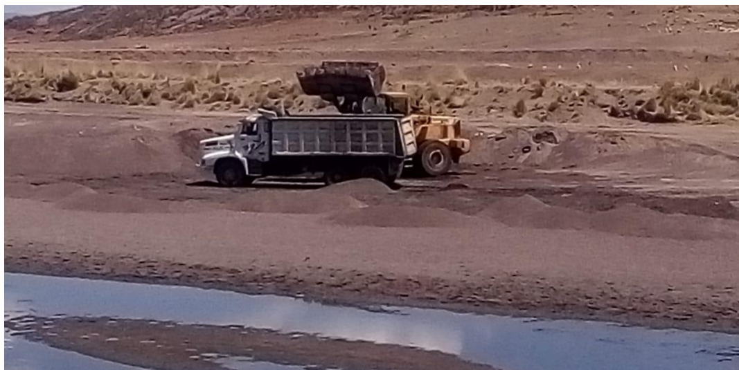
Figura 25:Proceso de carguío y transporte de arena
